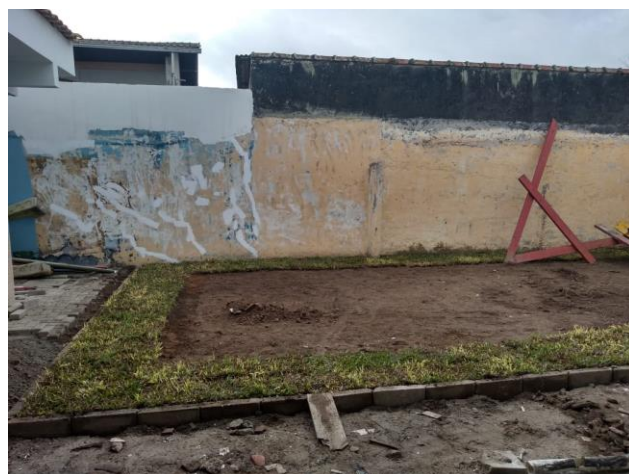
Finalização da obra em 2022:
